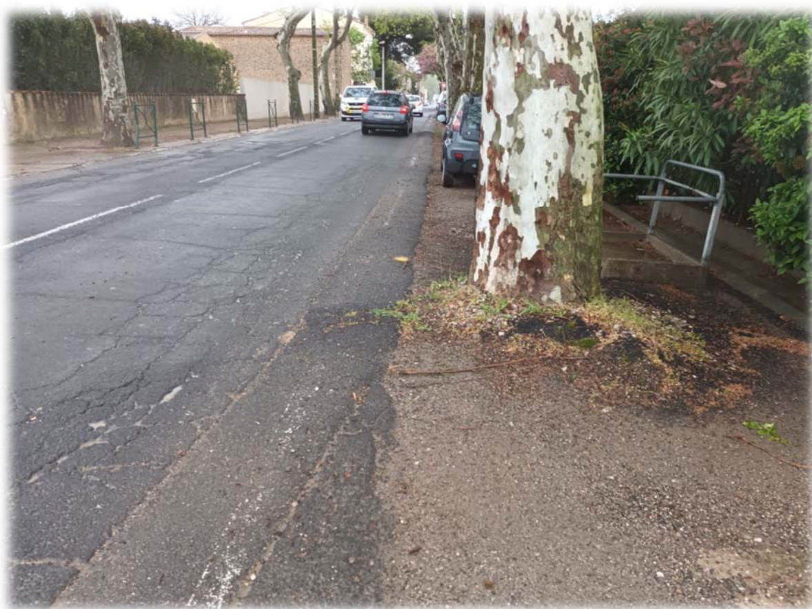
Haut de l'avenue de la Tuilerie – voie plus large : un piétonnier est aménagé à l'est, des arbres et des poteaux de réseaux aériens réduisent la largeur de passage et gênent la circulation piétonne
