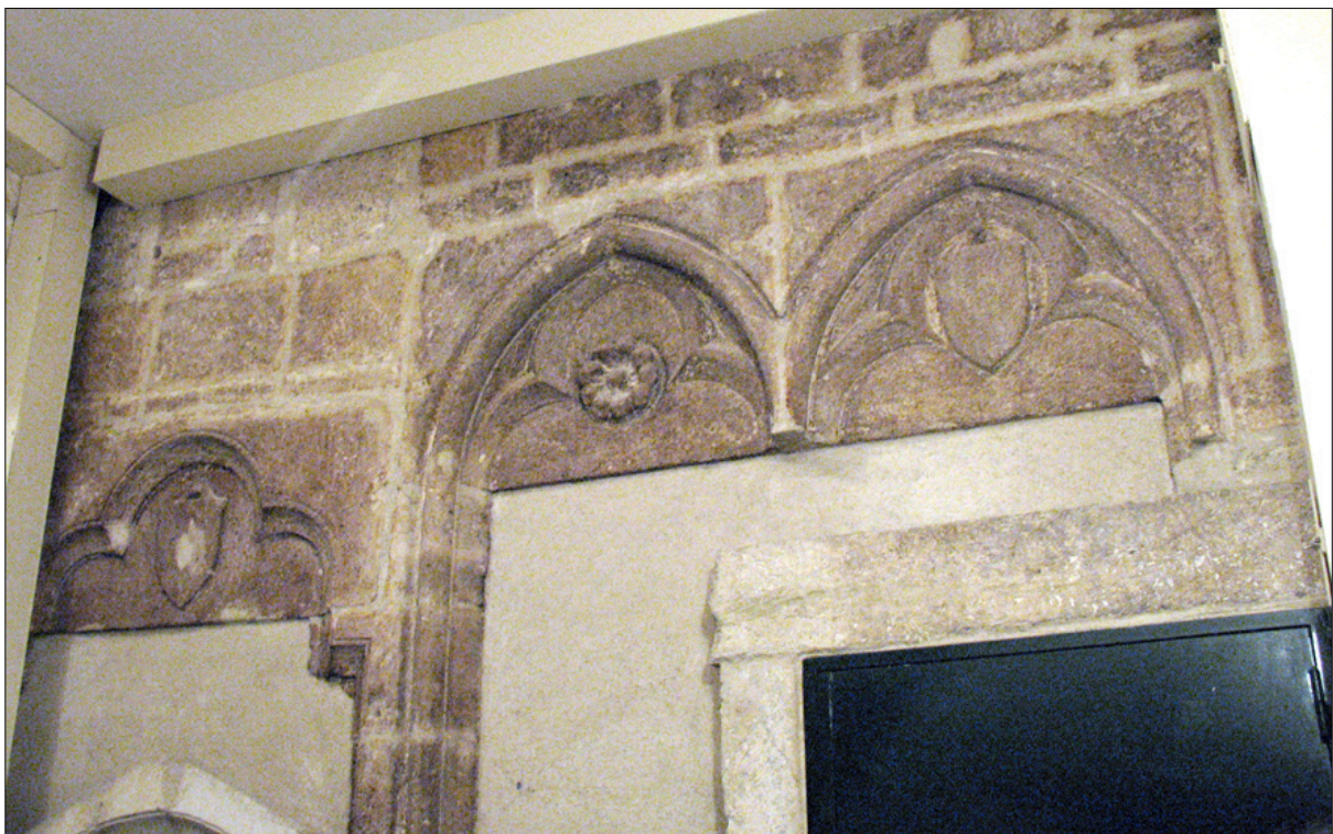
Fig. 35 12, rue de l'Université — porte et fenêtre géminée de l'ancienne façade en retrait (actuelle cage d'escalier)
