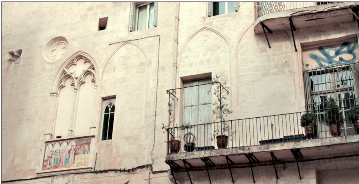
Fig.59 Place St-Ravy - la série de grandes baies à remplages de l'étage et les deux oculus polylobés
