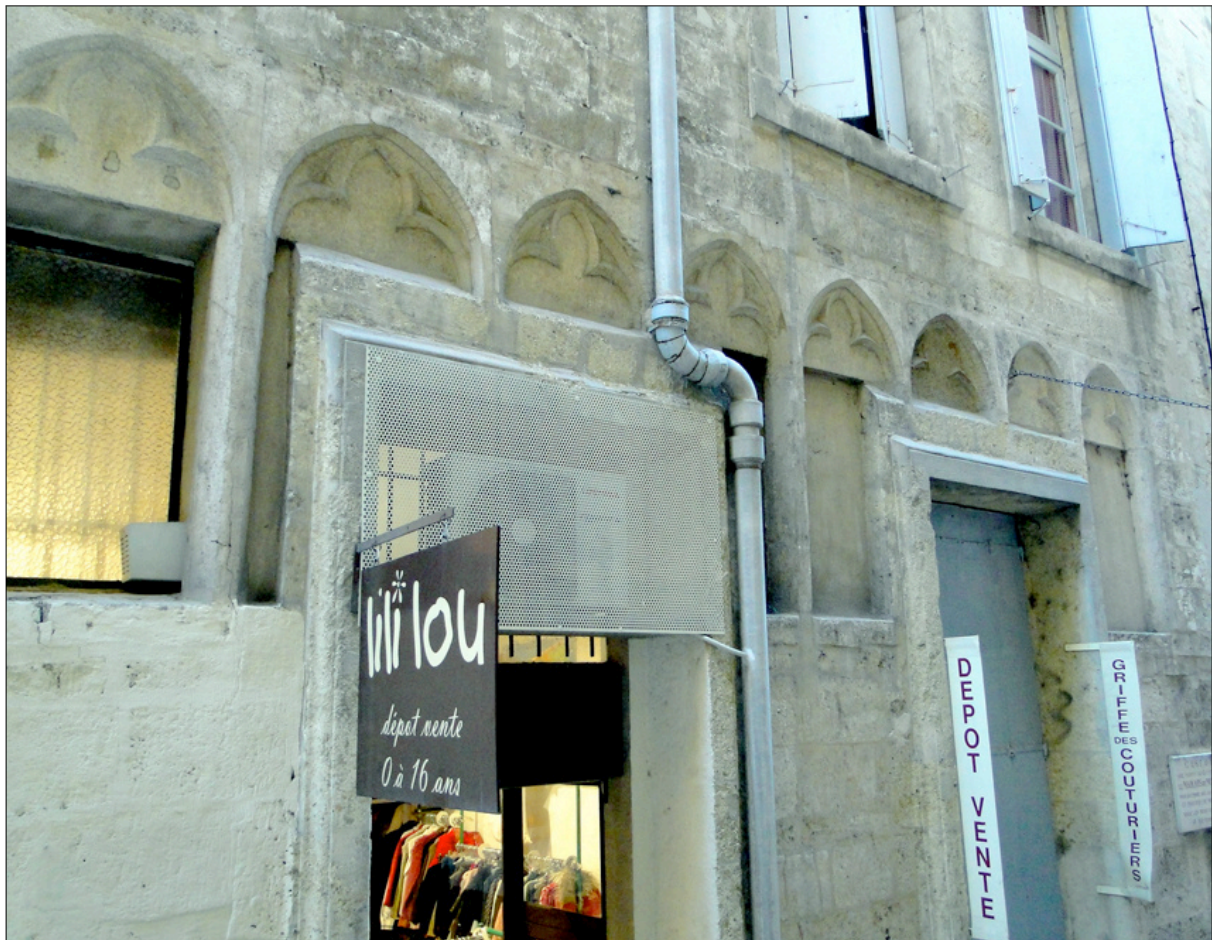
Fig. 50 3, rue de l'Ancien Courrier — claire-voie exceptionnelle, constituée de neuf lancettes, séparées par de simples meneaux
