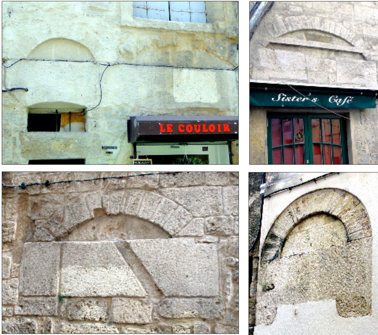
Fig. 7 : Montpellier - linteaux de pierre monumentaux surmontés par des tympans sous arc de décharge.
