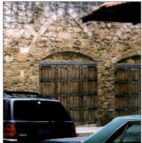
Fig. 5 : Liban - boutiques sous linteaux de bois
