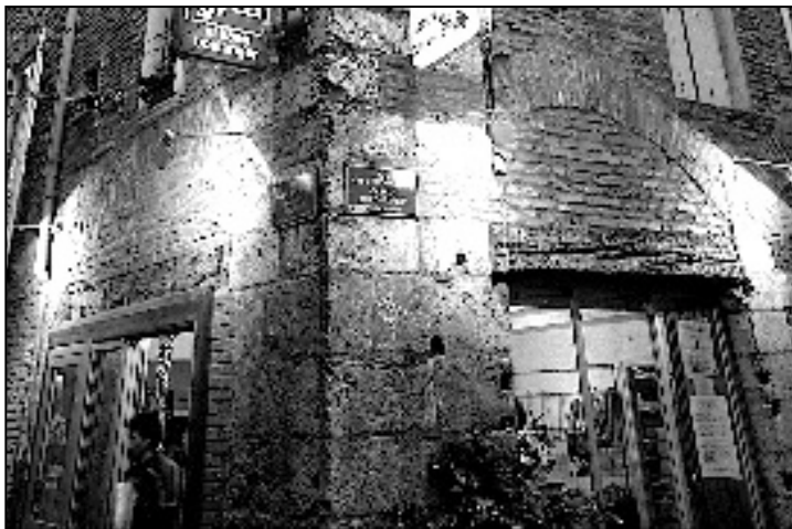
Fig. 4 – Perpignan - arcs de décharge
