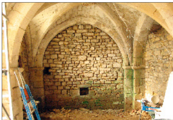
Fig. 15 – Gourdon (Lot), Salle voûtée d'une maison
