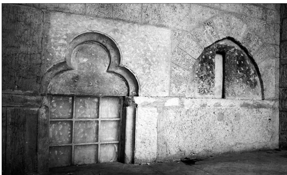
Fig. 12 9 rue de la petite loge - élément d'une façade en retrait d'alignement
