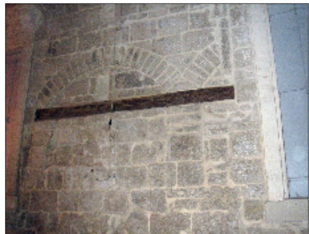
Fig. 6 : Montpellier - arcs de décharge et sablières filantes couvrant plusieurs baies par une seule pièce
