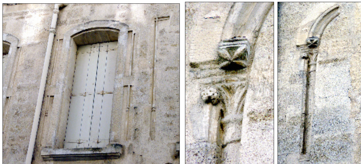
Fig. 31 14, rue du Pila-St-Gély — vestiges de croisées du 15 ème siècle et d'une fenêtre médiévale caractérisée par ses chapiteaux à crochets de style gothique primitif
