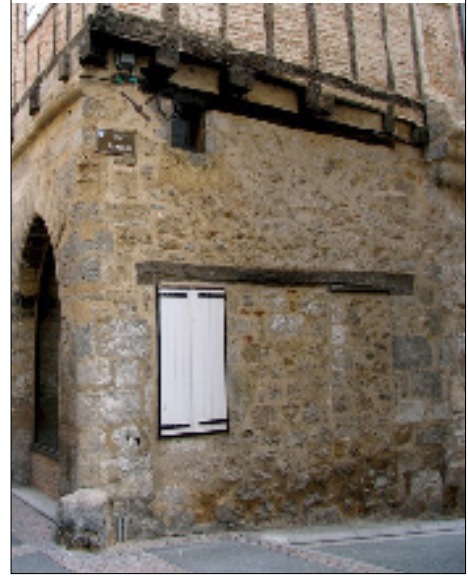
Fig. 3 : Figeac - boutique sous linteaux de bois
