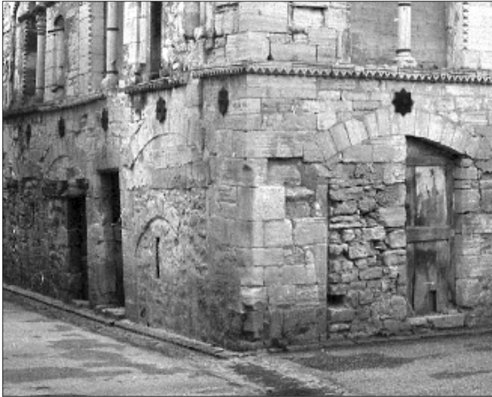
Fig. 2 : Villemagne-Largentière - boutiques sous linteaux de bois
